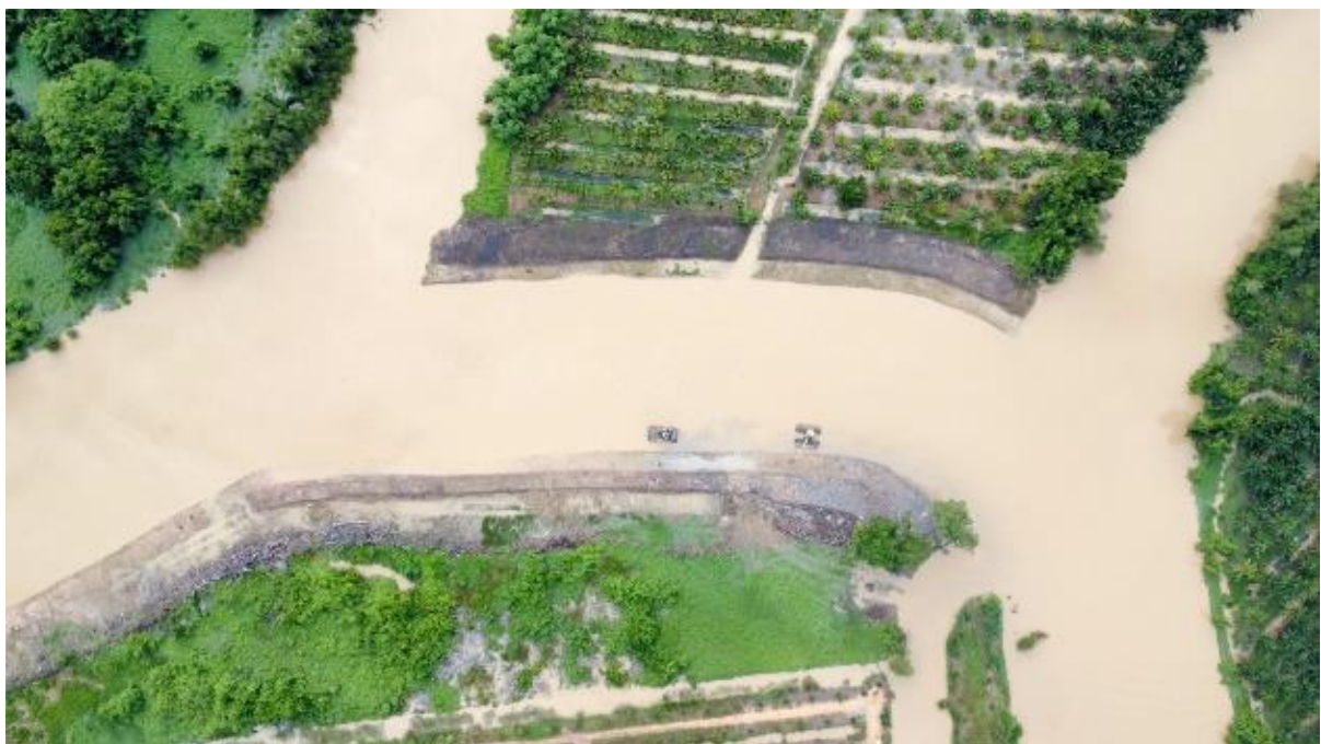
ภาพที่ 1-14 งานขุดขยายปรับปรุงคลองช่องลัดที่ 3
